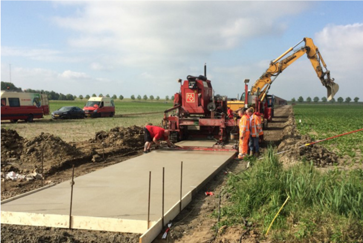
Aanleg van een 3 m breed kavelpad.
