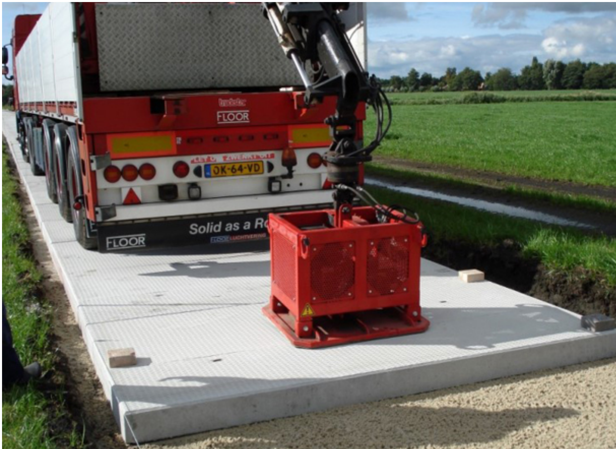
Aanleg kavelpad direct vanaf de vrachtwagen
