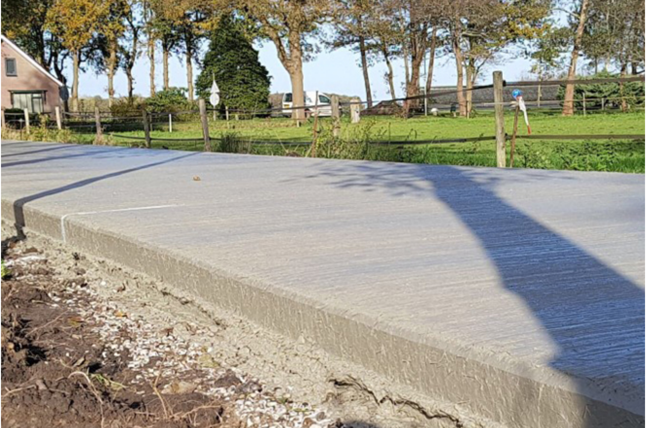
Het eindresultaat, de constructie bevat 400.000 vezels per kuub beton.
