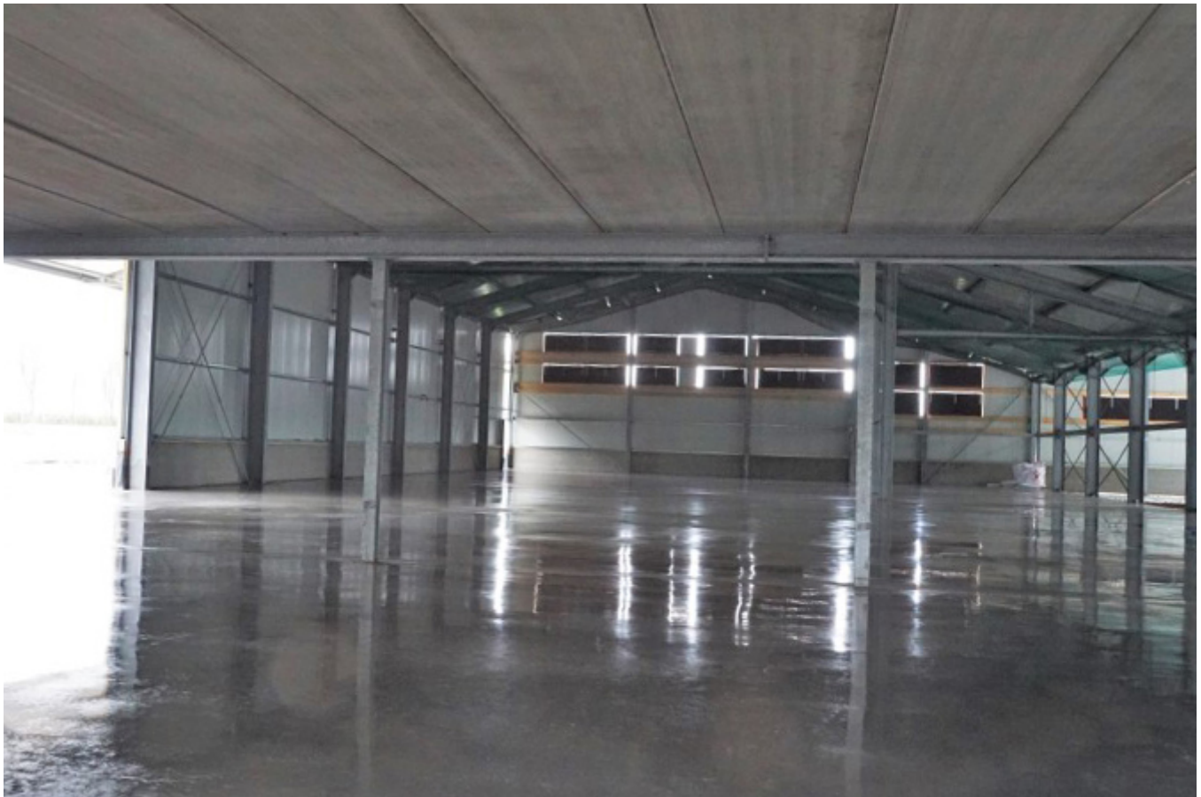
Foto: De loods van binnen met een betonnen zoldervloer.
