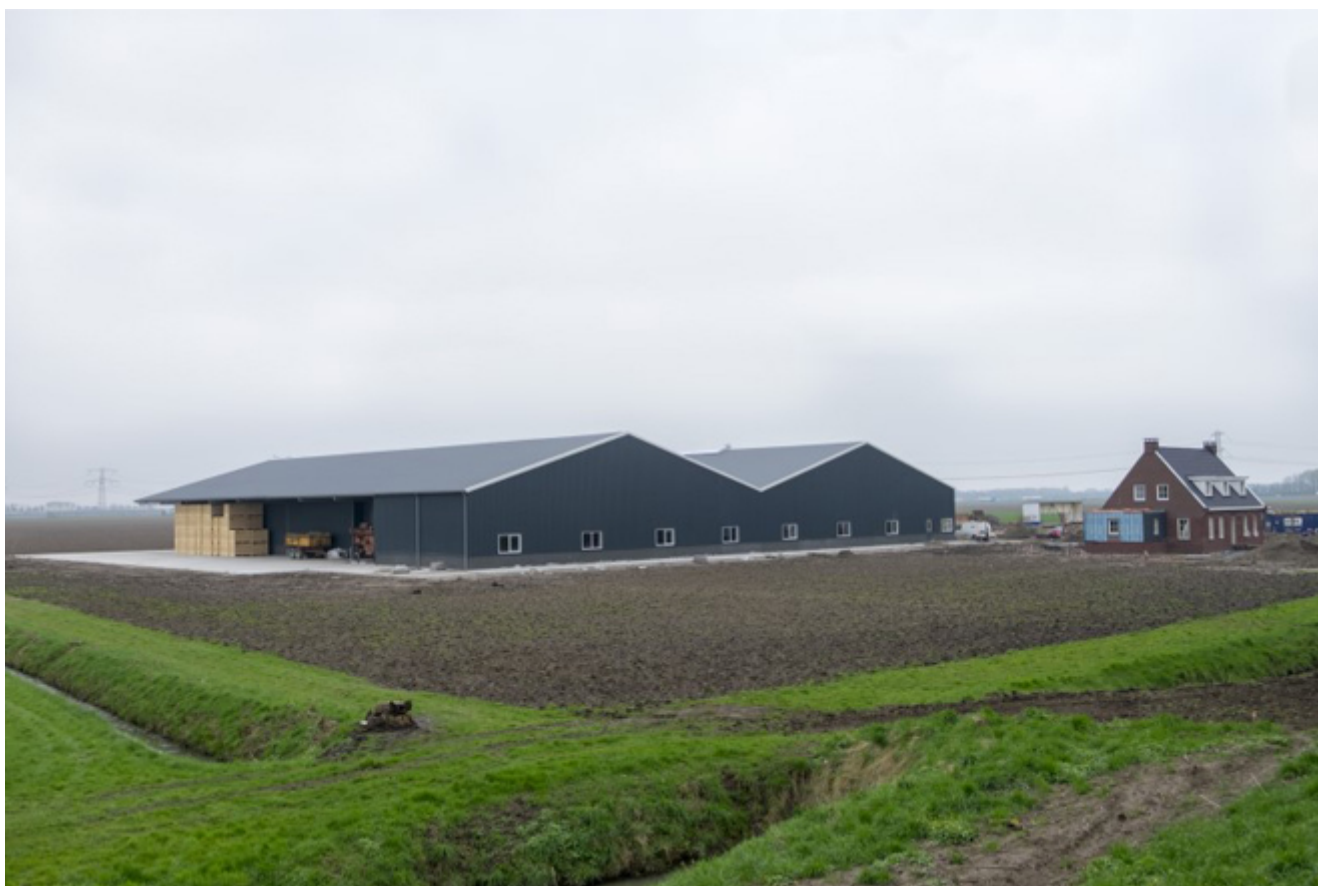
Foto: De loodsen zijn gereed.
