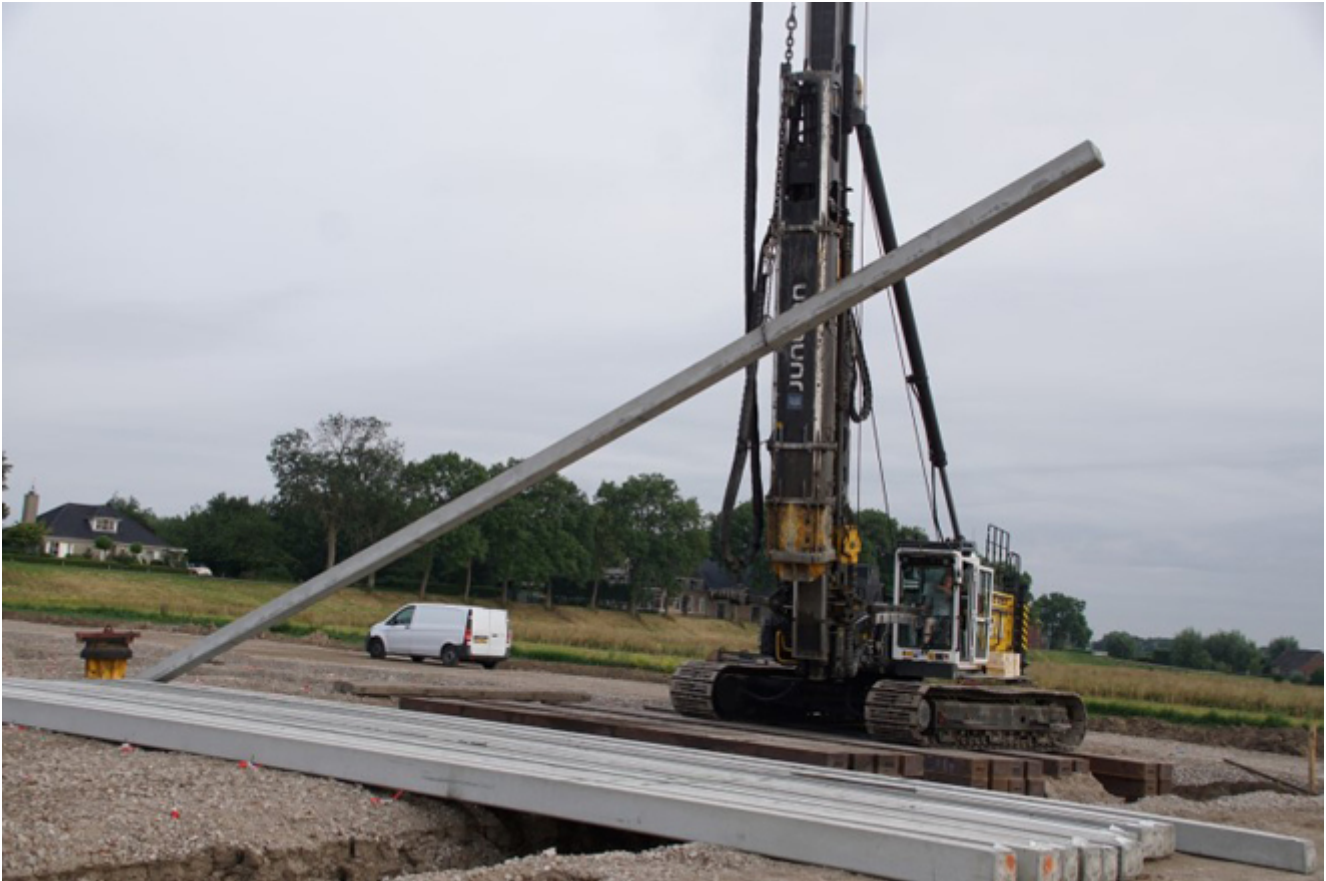
Foto: Voor de loodsen zijn zevenhonderd heipalen gebruikt.
