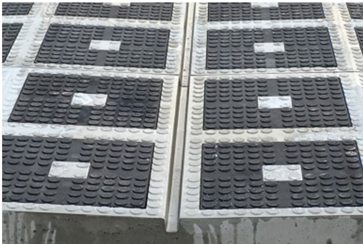
Dicht betonelement met rubberen delen in de uitsparingen.
